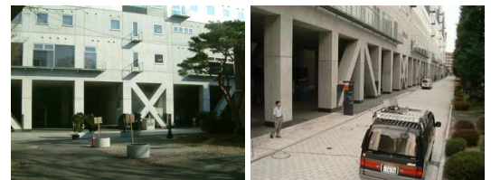
図 8 計測対象 (東京大学生産技術研究所): 柱は等間隔で、6m 毎に並んでいる．
