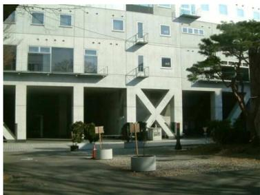
図 10: 計測対象 (東京大学生産技術研究所): 柱は等間隔で、6m 毎に並んでいる．
